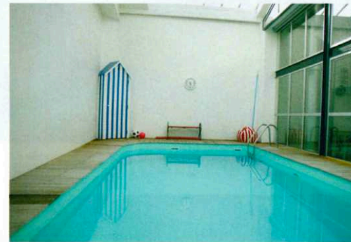
Photo de gauche et ci-dessus : La piscine de 7 x 3 mètres a été installée sous une cage en verre à cause de l'humidité. Le vitrage posé est un double vitrage standard.
