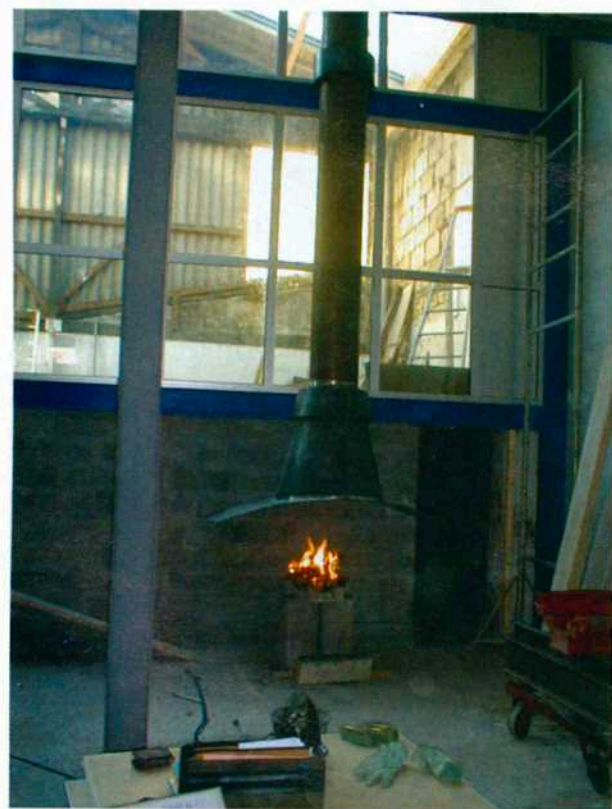
La présence d'une cheminée était l'une des exigences des propriétaires. Inexistante au moment de l'acquisition, elle paraît faire partie des lieux depuis des décennies.
