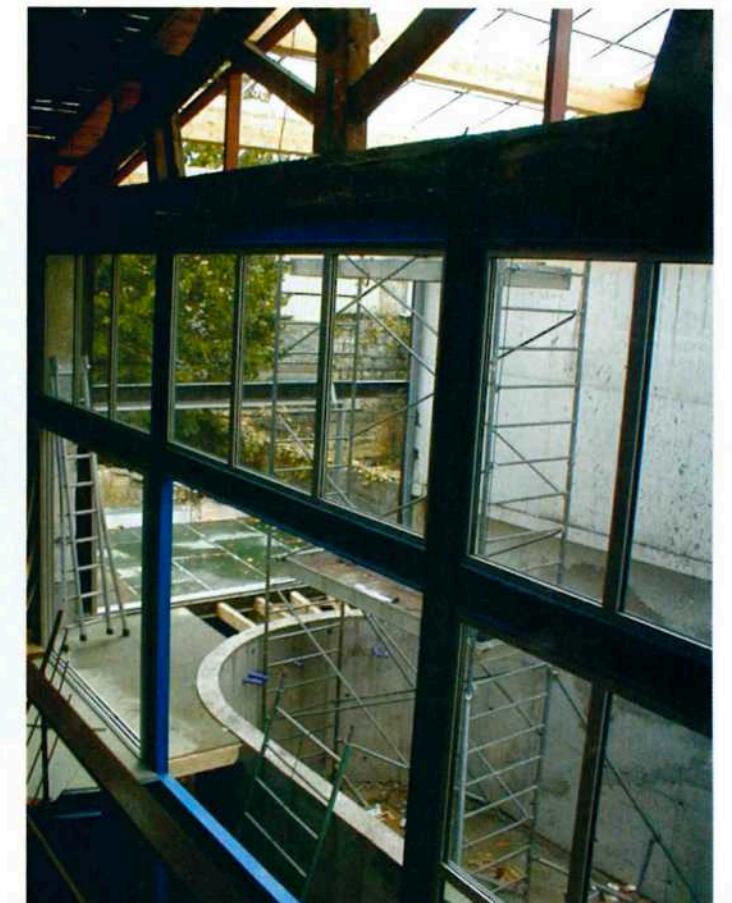
La piscine en béton banché coulé a été construite par une entreprise de maçonnerie. En dessous, on retrouve très logiquement la zone technique.
