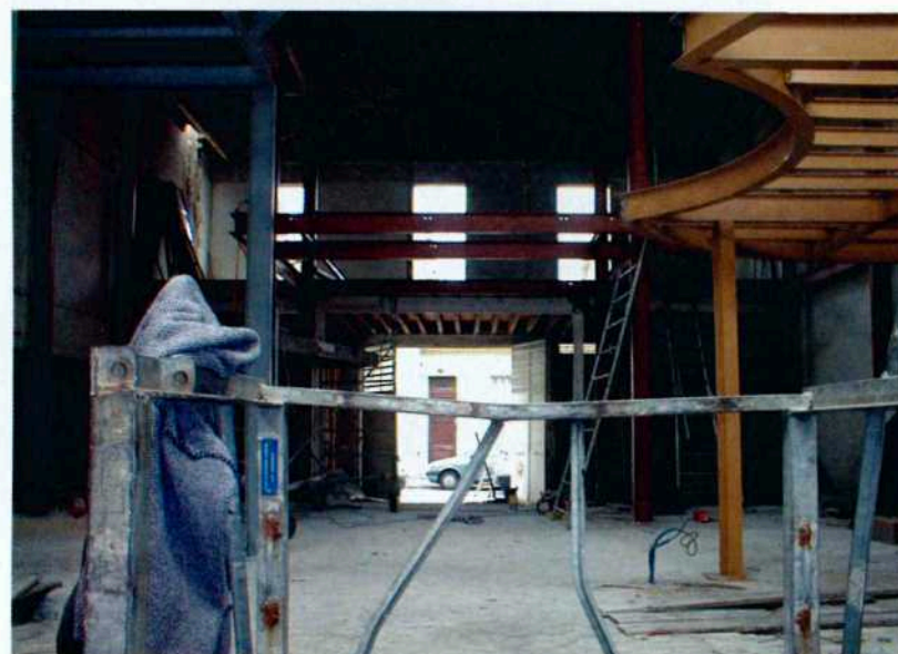
Pour créer différents niveaux et espaces, l'architecte Frédéric Martin a eu l'idée d'installer des mezzanines de part et d'autre du loft.
