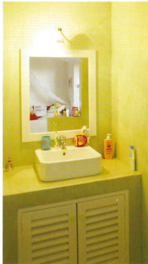
Le mur gris est un stuc ciment verni. Il reste, par sa dureté hydraulique, l'enduit idéal des sols et des surfaces exposés aux chocs.
