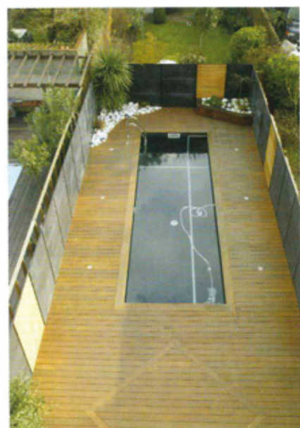
La piscine de 8 x 3 m est en blocs à bancher.
